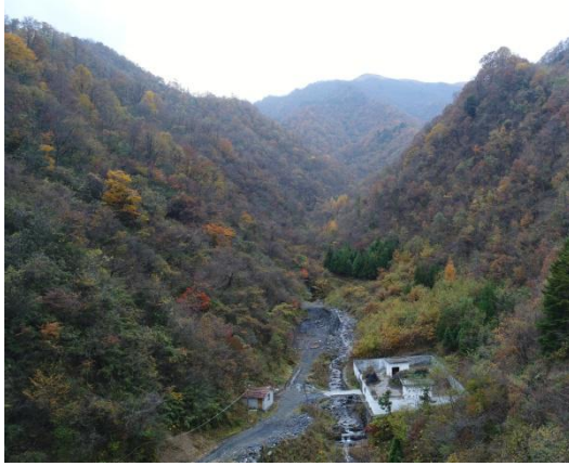
照片 3-4 俯瞰炸药库
