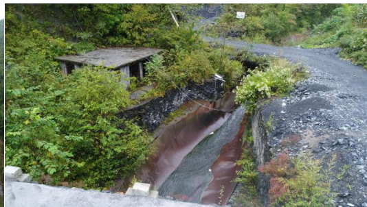
照片 3-10 钢板导流槽
