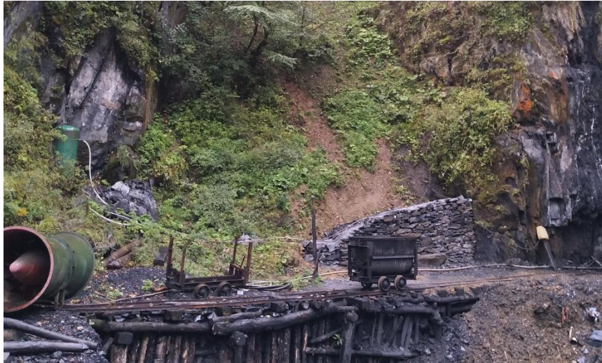
照片 3-11 通风井口干砌石拦挡墙
