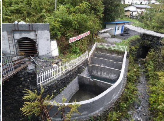
照片2-5 三级沉淀池、值班室
