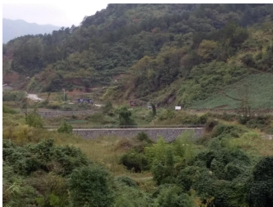
照片 2-3 剪脂沟拦渣坝
